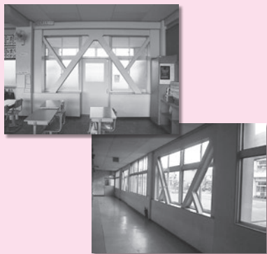
耐震補強に伴い斑鳩小学校に設置された鉄骨ブレース
